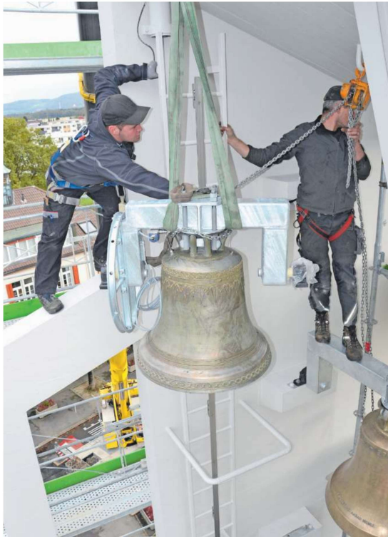
Glockenmontage in luftiger Höhe bei der Kirche Hunzenschwil
